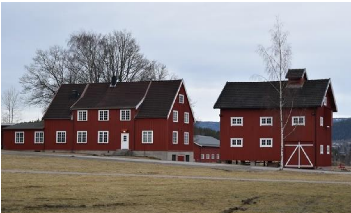
Snekkerverkstedet og magasinet er fra 1911, og er del av det eldste miljøet fra landbruksskolens oppstart. Bygningene er svært autentiske. Begge er i bindingsverk kledd med lektepanel, og vinduer med småruter.
