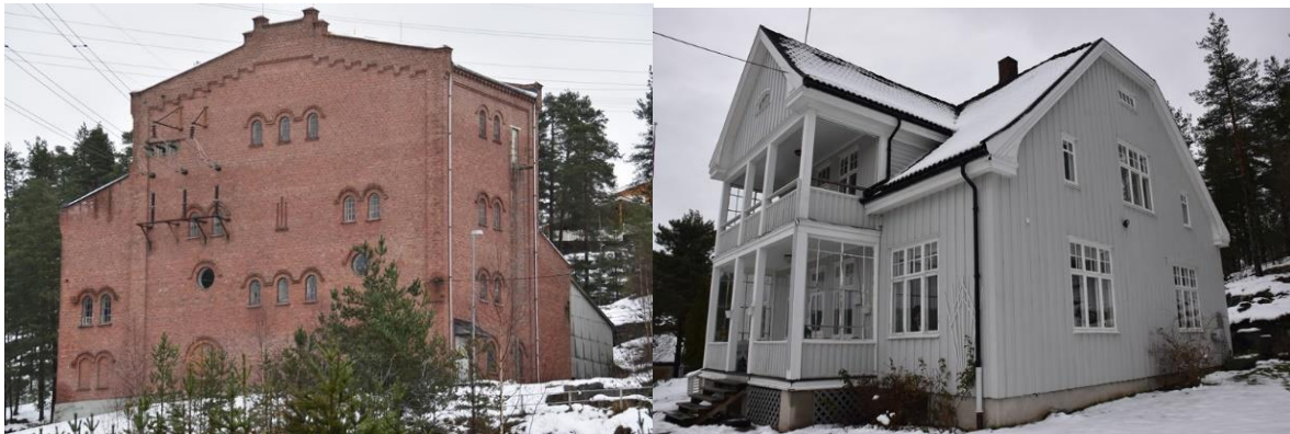
Gravfoss transformatorstasjon, bygd 1905-10. Maskinmesterboligen er bygd ca. 1910.
