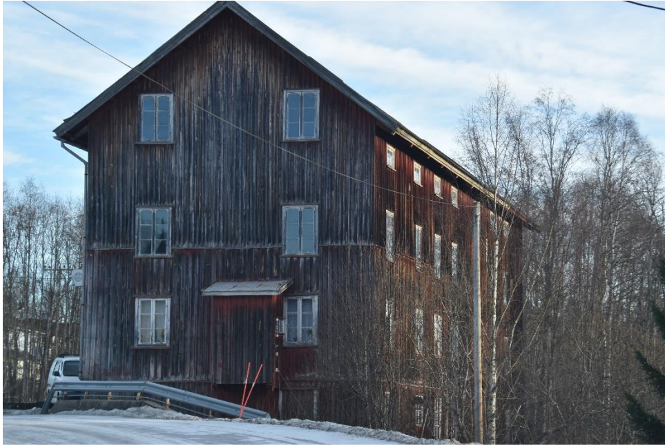
Bygningen ligger inntil Syslebekken.
