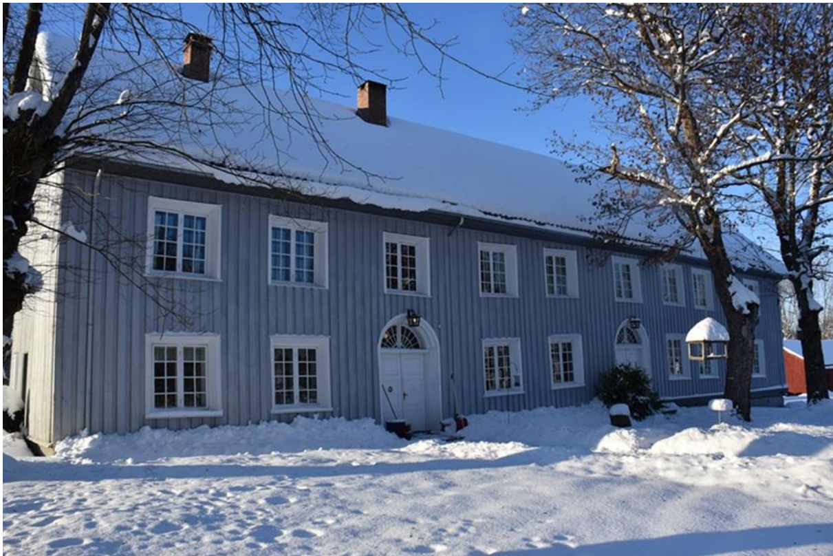
Våningshuset på Mælum på Åmot skal være bygd i 1707, ombygd i 1762. Det ble fredet i 1923. Sorenskriver Otto Darjes kjøpte gården i 1759. Han tilhørte den rike kretsen av borgere med forbindelse til Christiania. Han bygde om den eldre hovedbygningen i perioden 1762-1765, etter tegning av sin gode venn James Collett på Bogstad. Den såkalte Bacchuspokalen fra Nøstetangen, som viser et opptog av mytologiske naturvesener fra Bogstad i Sørkedalen via Mælum til Buskerud gård, ble trolig bestilt til denne anledningen. Gården ble i 1790 overtatt av sønnen Peter Resen Darjes (f. 1757), og i 1828 av hans svoger Auen Gregersen (f. 1803), den første ordføreren i Modum.
