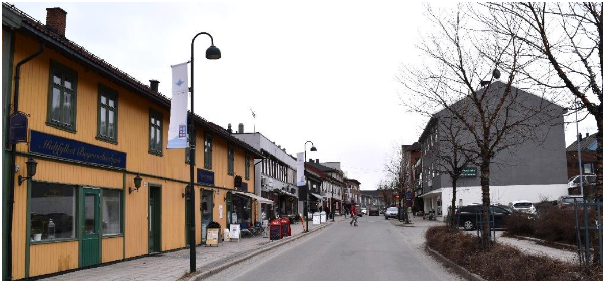
Vikersundgata. Her gikk tidligere riksveien gjennom tettstedet.
