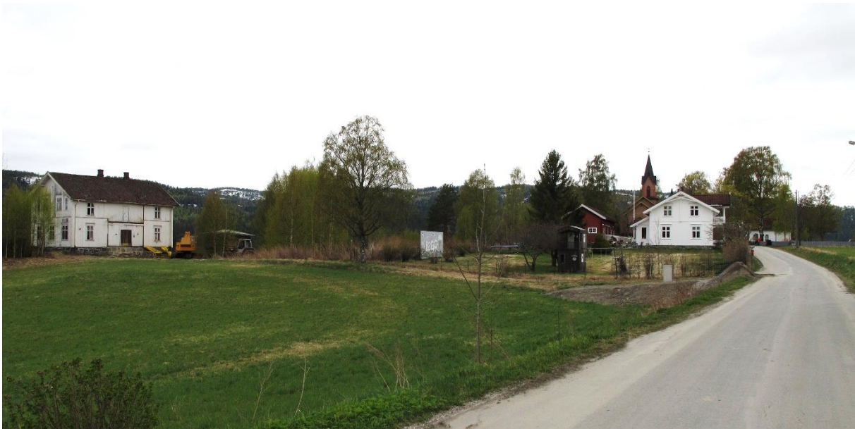
Den gamle Lofthusskolen til venstre, Kirkebø hotell til høyre. Lofthusskolen er under rehabilitering.
