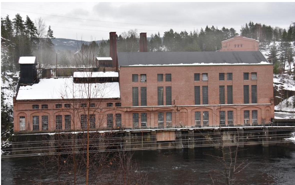
Gravfoss kraftstasjon, bygd 1903.
