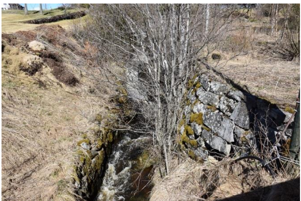
Røret fra rørgata er brukket av og ligger nå på bakken ved siden av bekken. Nederst er kantene langs bekken fint oppmurt.
