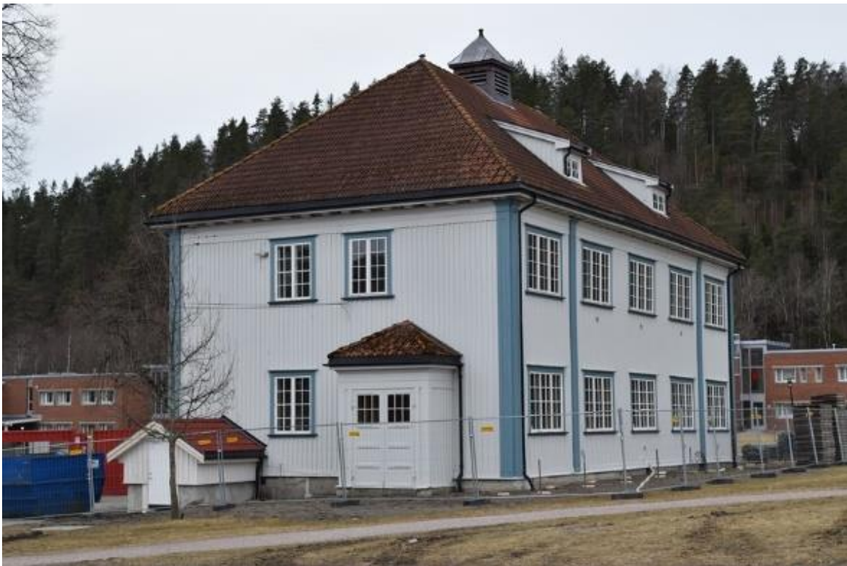
Kontorbygningen t.h. er fra 1911 og ble bygd som undervisningsbygg da skolen ble opprettet. Det er en toetasjes bygning i reisverk kledd med lektepanel, vinduer med småruter, valmtak, og nyklassisistiske detaljer. Den har høy arkitektonisk verdi og høy grad av autentisitet.
