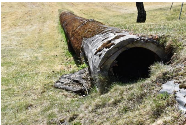
Røret fra rørgata er brukket av og ligger nå på bakken ved siden av bekken. Nederst er kantene langs bekken fint oppmurt.
