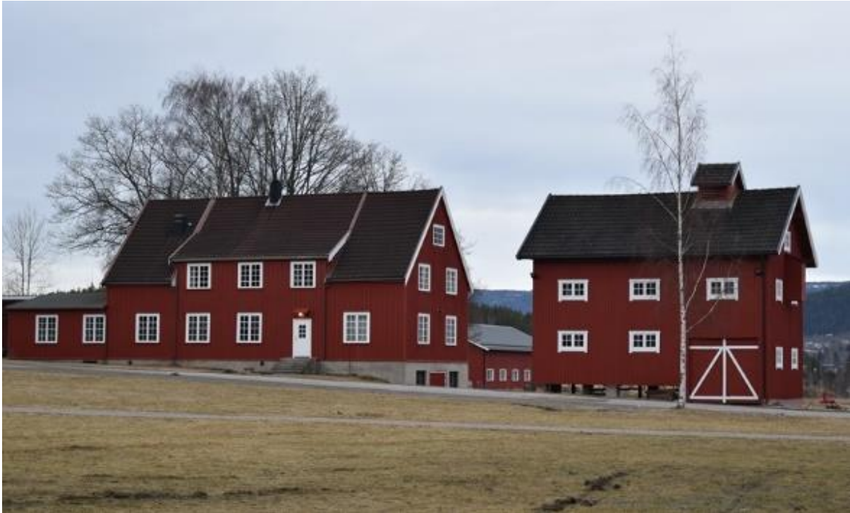
Snekkerverkstedet og magasinet er fra 1911, og er del av det eldste miljøet fra landbrukskolens oppstart. Bygningene er svært autentiske. Begge er i bindingsverk kledd med lektepanel, og vinduer med småruter.
