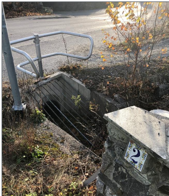
Figur 20: Kulvert nord for leilighetsbygg, ved undergang under jernbaneskinnene mellom Geithusveien og Øvregata.
