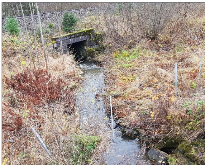
Figur 19: Kulvert ved Bekkefarene ved avkjøring til Fv. 284.
